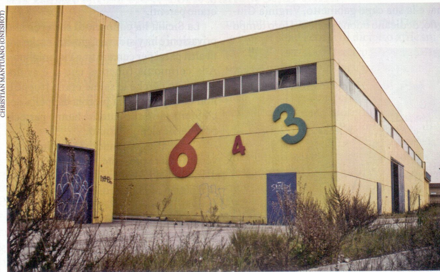
Bari, 15 marzo 2014. Capannoni abbandonati del centro commerciale Aiazzone
